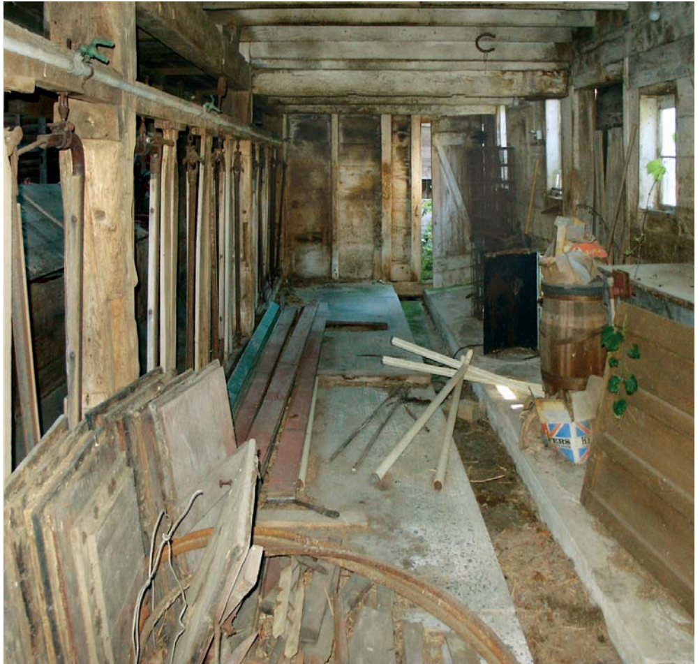
12 - DE STALINRICHTING IN DE ZIJBEUK VAN DE DUTCH BARN. DE MESTGOOT IS NOG AANWEZIG, MET DAARACHTER HET PAD OM DE MEST WEG TE KRUIEN. DIT IS EEN SITUATIE DIE IN NEDERLANDSE BOERDERIJEN OOK WERD AANGETROFFEN. FOTO JUDITH TOEBAST
