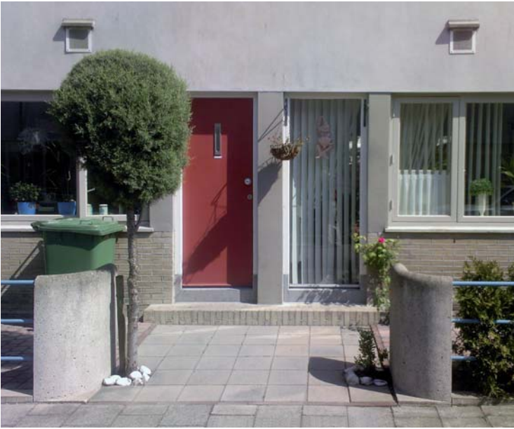
9 – OM HET RIJKSMONUMENT DE KIEFHOK VAN J.J.P OUD FUNCTIONEEL TE BEHOUDEN VOOR GEZINNEN WERD BIJ DE VOLLEDIGE RECONSTRUCTIE VAN DE ROTTERDAMSE ARBEIDERSWIJK EEN DEEL VAN DE WONINGEN SAMENGEVOEGD. DE GEDEELTELIJKE VERVANGING VAN RODE DEUREN DOOR VENSTERS GING TEN KOSTE VAN DE PAARSGEWIJZE RITMIEK BINNEN HET ENSEMBLE.
