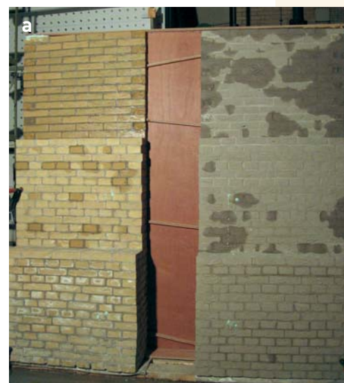
6A NA 1-UUR BEREGENING (ZONDER OVERDRUK). 38 MINUTEN NA DE AANVANG VAN DE BEREGENING WAS DE GELE (STERK ZUIGENDE) 1/2-STEENS MUUR REEDS VOLLEDIG DOORGESLAGEN. BIJ DE GELE 1-STEENS MUUR KOMT DUIDELIJK NAAR VOREN DAT DE STENEN (KOPPEN) DOORSLAAN.
